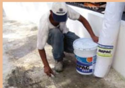
**Paso 2:** Estando fresca la primer mano de impermeabilizante, se recomienda colocar una tela de refuerzo para mejorar las resistencias del sistema.
