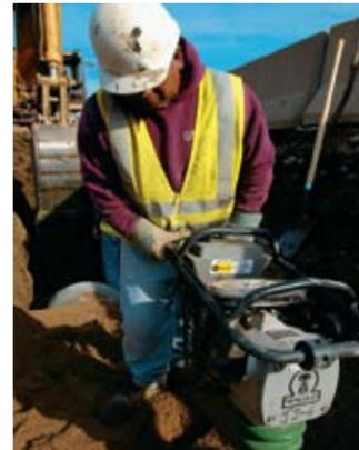
Los apisonadores han sido diseñados para la compactación en áreas confinadas de suelos granulares, Altura de salto hasta 65(mm).
