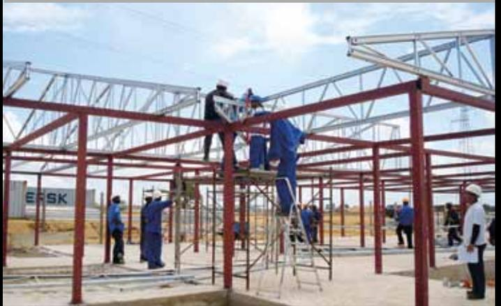
**Techo Total:** sistema de cerchas prefabricadas como solución ante las diferentes necesidades de cubierta que se presentan en el mercado de la construcción. Este sistema combina el uso de hierro galvanizado de bajo calibre, secciones de eficiencia estructural y un sistema patentado de unión remachada.
