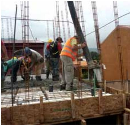
Kodiform . Tablas hechas de OSB (Oriented Strand Board, por sus siglas en inglés), que conforman un panel estructural de astillas o virutas de madera, orientadas en forma de capas cruzadas para aumentar su fortaleza y rigidez. Diversas aplicaciones, entre ellas la de formaleta.
